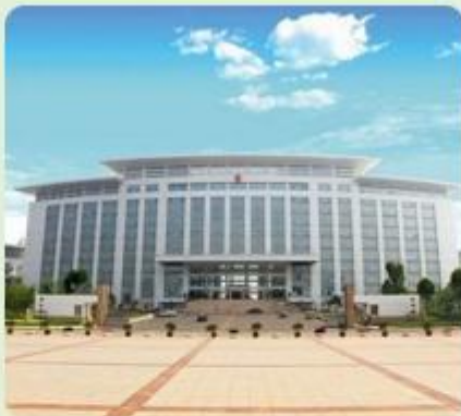
抚州市临川区行政中心
